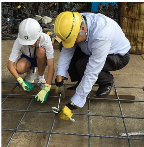
国府中学校2年生「ワクワク体験学習」のようす。 工具（ハッカー）を使って、鉄筋どうしを針金で結束する体験。
