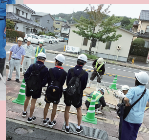
舗装補修工事見学
