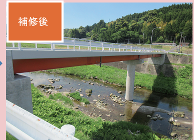
塗装塗替え、防護柵補修事例
